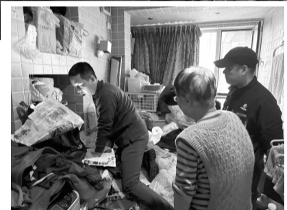
查看漏水情况
